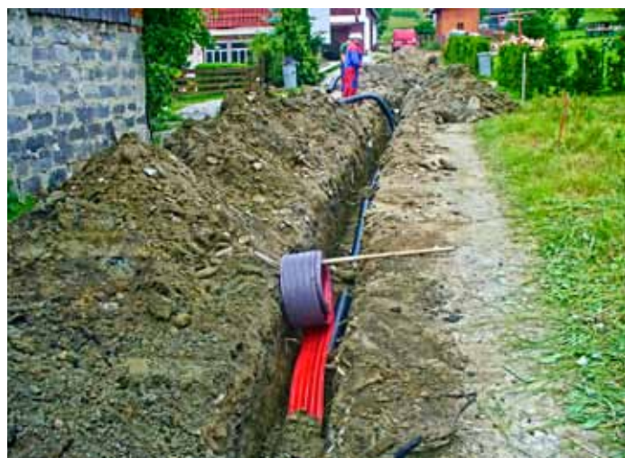
Prívod a uloženie kábla k trafostanici
