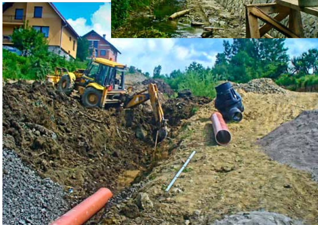
Súčasťou projektu Revitalizácia centra v obci Klin je aj výstavba dažďovej kanalizácie na rekonštruovanej ceste a novom parkovisku
