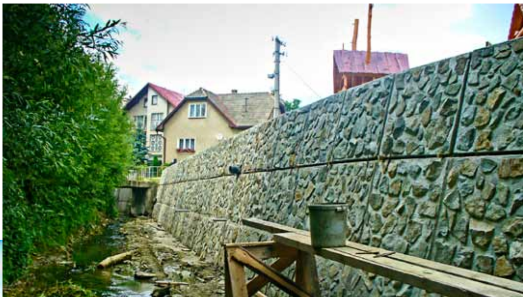
Výstavba oporného múru na potoku Kliňanka v rámci projektu Revitalizácia centra v obci Klin
