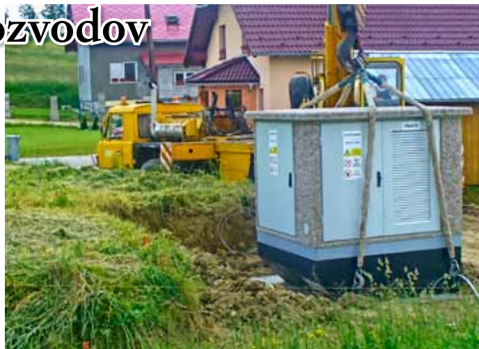
Osadzovanie trafostanice v lokalite Pod Grapou
