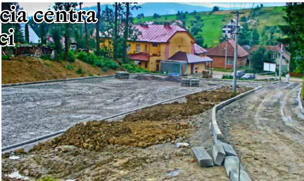
Pohľad na rozostavané nové parkoviisko a rekonštruovanú cestu v rámci projektu Revitalizácia centra v obci Klin
