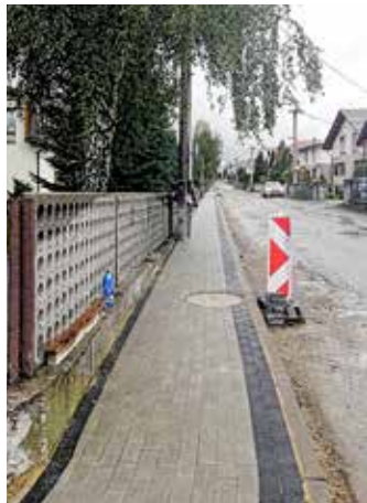
Výstavba chodníka na ul. Školská
