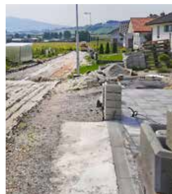
Stavebné práce na ul. Roveň pred asfaltovaním
