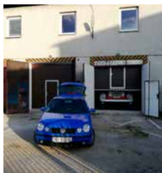
Výmena garážových brán v administratívnej budove bývalej prevádzky
