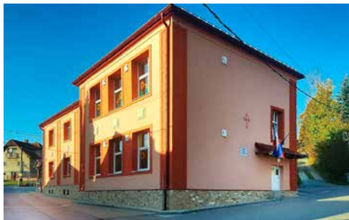
Rekonštruovaná dolná MŠ – spredu
