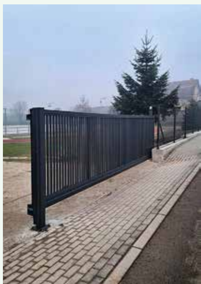
Rekonštrukcia oplotenia pri vynovenom ihrisku pri ZŠ
