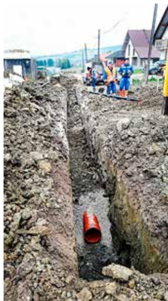
Vodovod a kanalizácia Roveň
