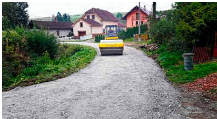
Ul. Hlboká – úprava cesty pred asfaltovaním
