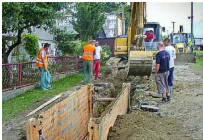
Práce na kanalizácii pri ZŠ
