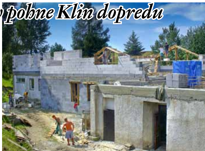
Práce na MŠ. Materská škola dostane novú tvár.
