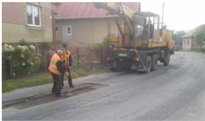
28. 8. 2013 MBM – stav Námestovo zabezpečilo v rámci reklamačného kona- nia opravy cesty III. triedy a miestnych komunikácií po vybudovanej kanalizácii
