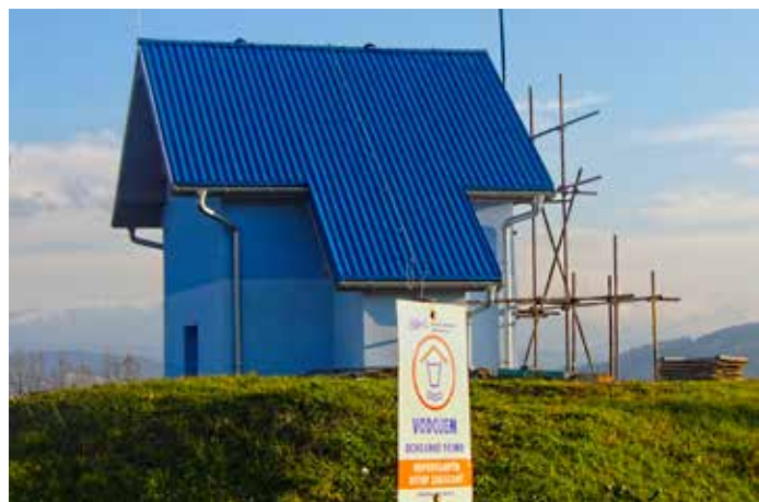
13. 9. 2013 Zrekonštruovaný vodojem na I. tlakovom pásme nad kostolom
