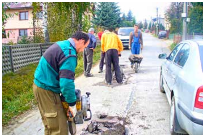
13. 9. 2013 Oprava miestnych komunikácií
