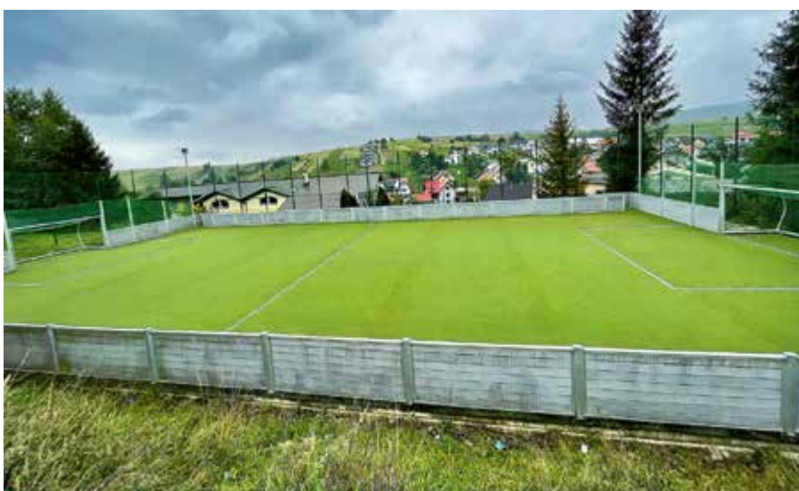
Oprava multifunkčného ihriska pri hornej MŠ
