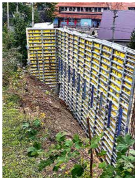
Výstavba oporného múru pri hornej MŠ – pohľad zhora
