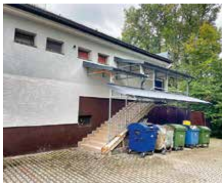
Prestavba a zastrešenie bočného vchodu OcÚ a maľovanie strechy OcÚ
